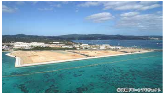
埋め立てが進む辺野古沿岸部＝14日、名護市辺野古 (沖縄ドローンプロジェクト提供) ／（琉球新報 2021 年 12 月 15 日より）
